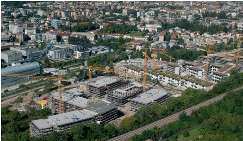
^ Cantiere Residenza San Bartolomeo Foto: AGF Bernardinatti
