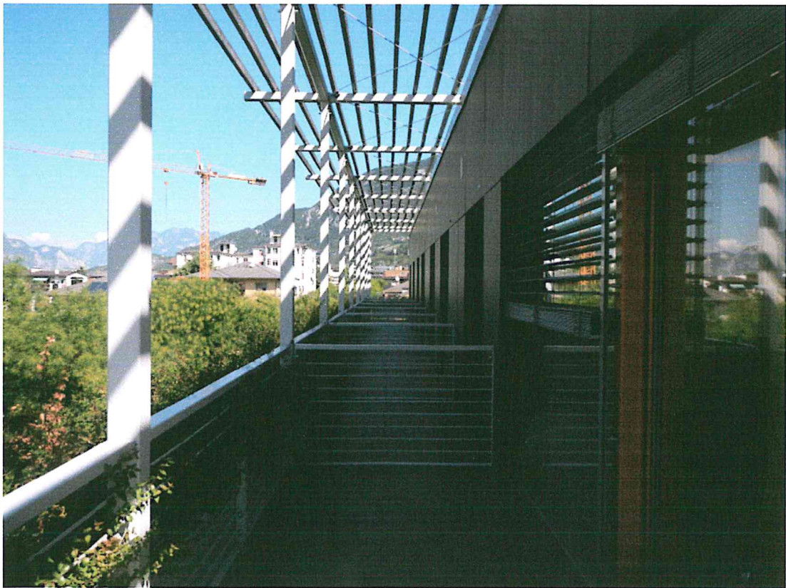
Balcone sul lato ovest del corpo A al 4^ piano
