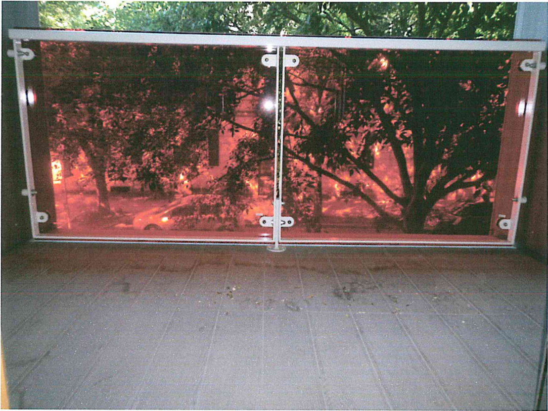
Particolare di un parapetto a struttura metallica e pannellatura in vetro
