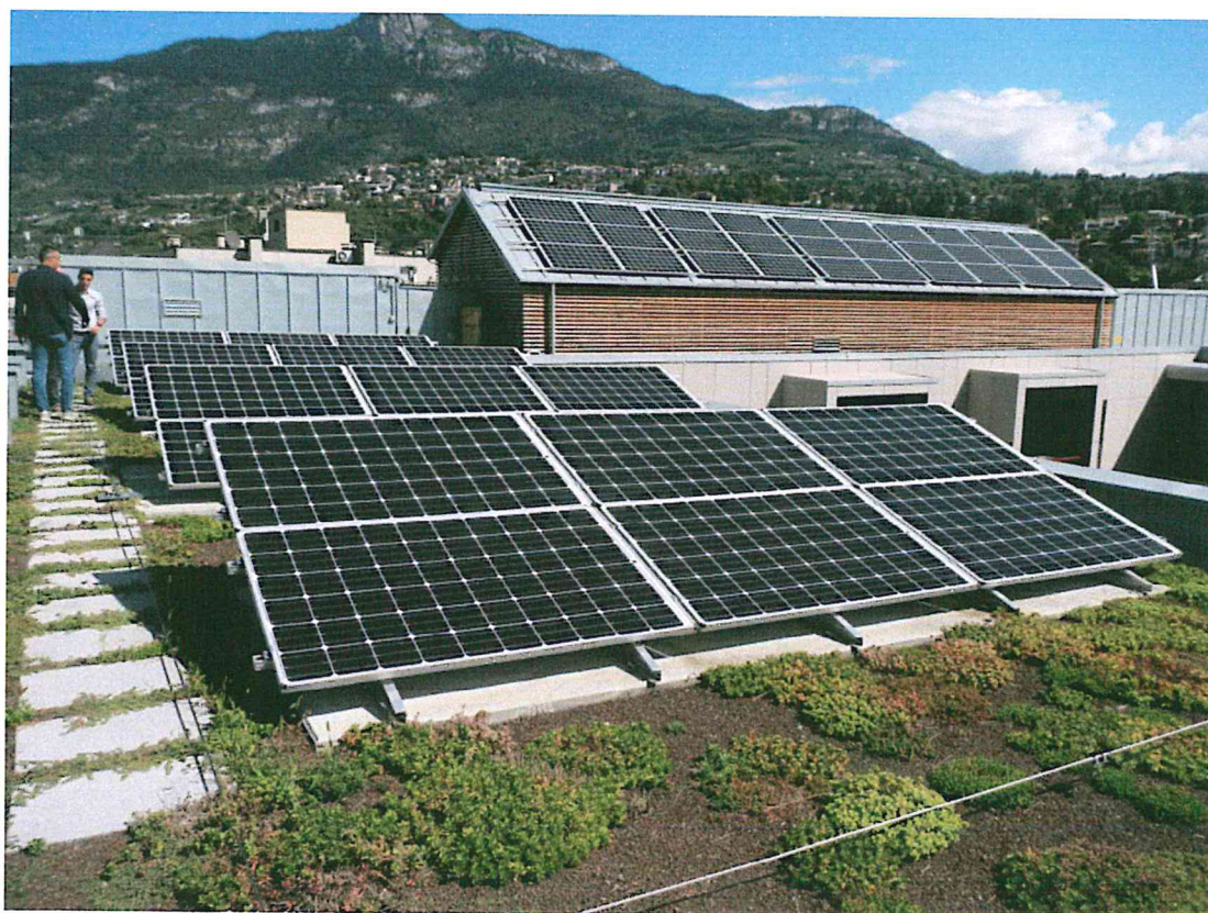
Tetto verde e volume impianti con pannelli fotovoltaici
