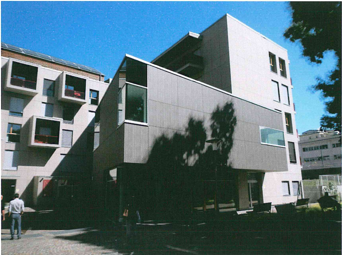
Corpo D visto da via Lampi
